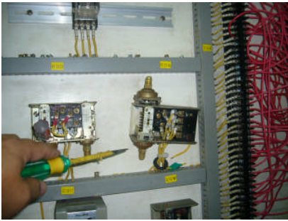
4 夾低壓壓力開關 (停止運轉)
