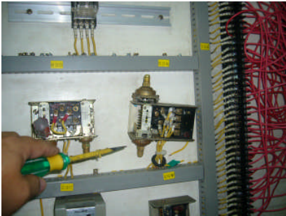
10 測電壓電流
