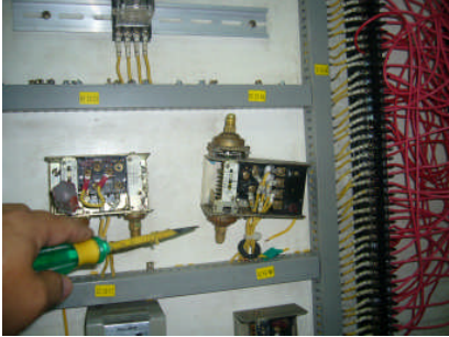
4 夾低壓壓力開關 (停止運轉)
