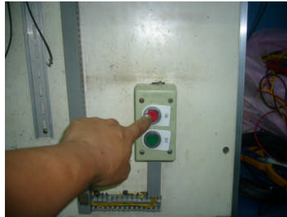
9 拉油壓壓力開關 (停止運轉) 復歸後重新啟動
