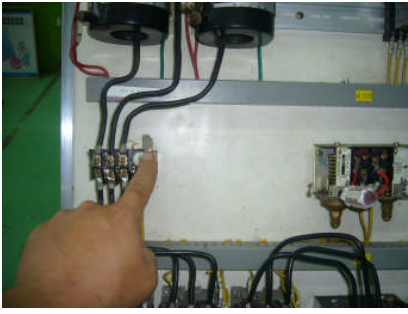
3 拉高壓壓力開關 (停止運轉)
