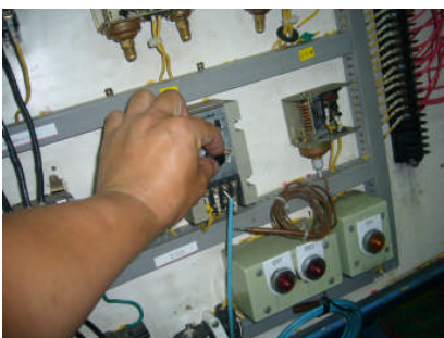
7 試電磁閥是否激磁
